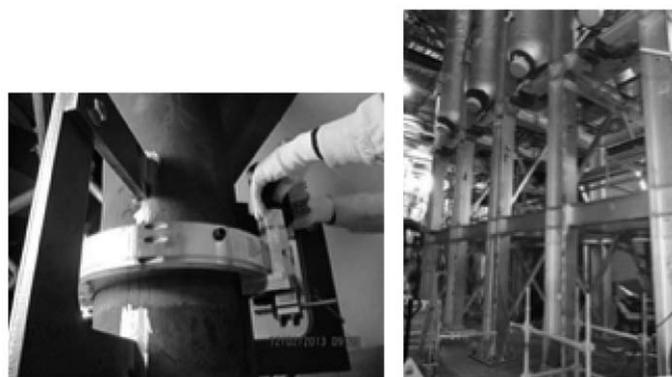
図8 熱交換器の接続配管にセットした切断装置（オービタルソー）と切断後の熱交換器
