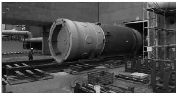
図 15 炉内構造物を撤去した 2 号炉の原子炉圧力容器の搬出
