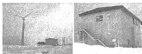
(a) 蓄電池建屋外観(冬期)
