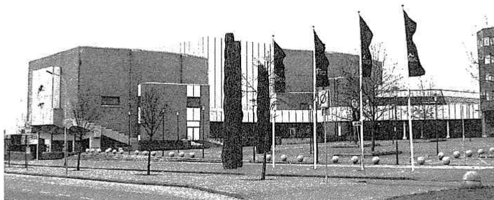
図2 マーストリヒ・コンファレンス・センター全景
