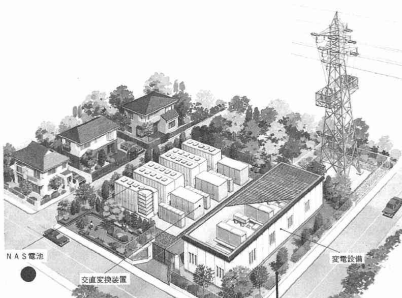
図5 NAS電池の配電用変電所への設置例 (9)
