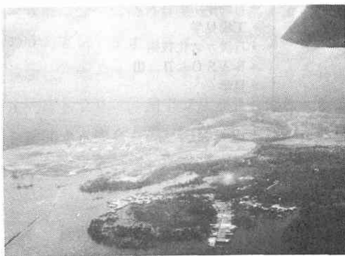
写真1 バダック LNG プラント プラントサイトの全景、中央にタンク(9,500m 3 /基×4基)が見える。
