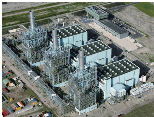
図 11 Nuon Magnum 発電所の外観
