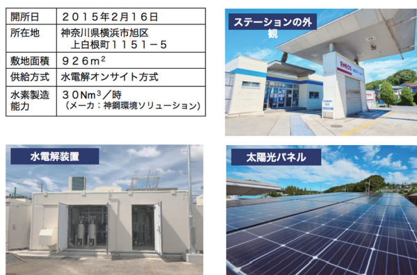
図10 再エネ電解型水素ステーション（横浜旭ST）
