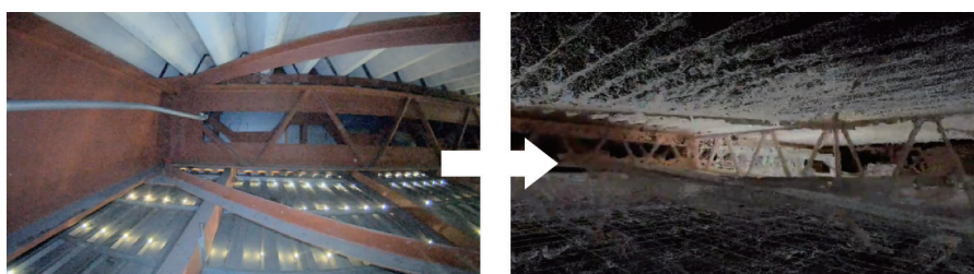
図7 天井裏の点群化
