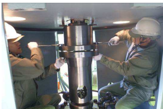
ポンプ分解・組立（実習） 受講者によるポンプ分解
