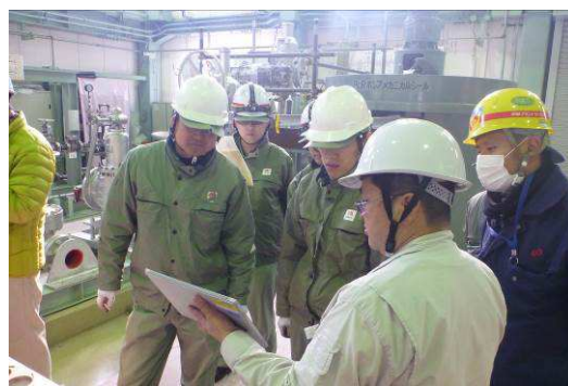
メカニカルシール分解・組立（実習） タブレット端末による説明
