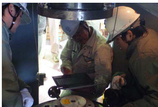
ポンプ分解・組立（実習） タブレット端末による手順確認
