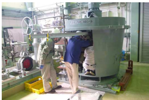
PLRポンプ模擬訓練設備
